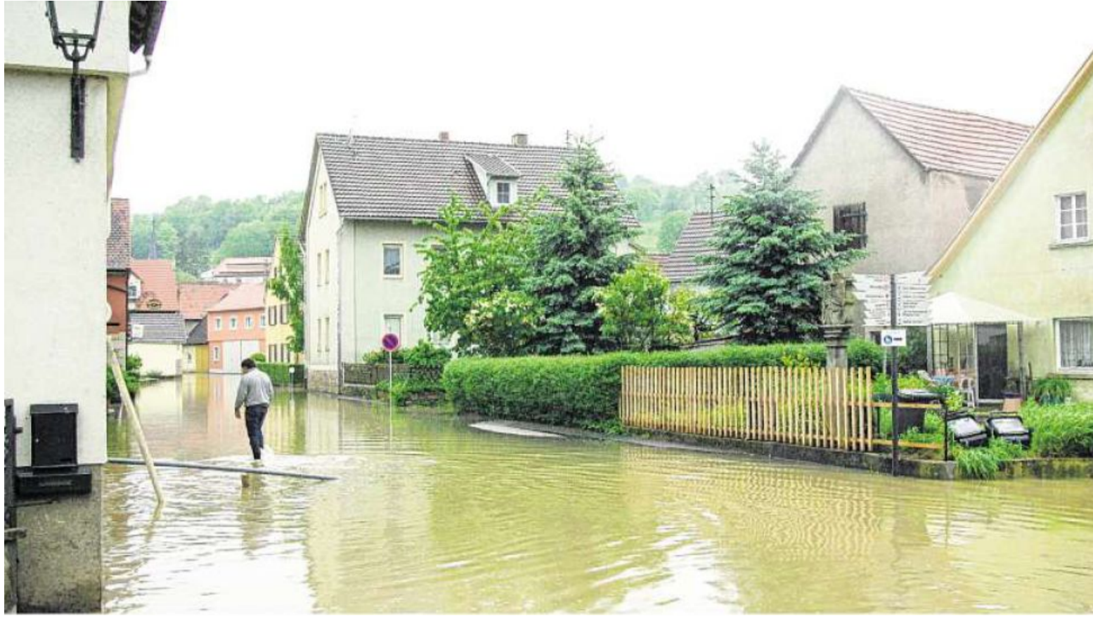
Jahrhunderthochwasser, wie hier in der Untergasse, kommen mittlerweile nicht nur alle 100 Jahre vor. Starkregen ist die neue und noch zu wenig beachtete Gefahr. Die Stadt Röttingen will sich darauf bestmöglich einrichten. FOTO: ARCHIV MARKHARD BRUENECKER
